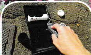
3. Pune vopseaua în tava trafolet, înmoaie rola în vopsea și îndepărtează excesul.
